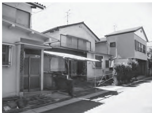
写真6 放置された空き家例 (ロープで囲った左と中央) (U団地)
